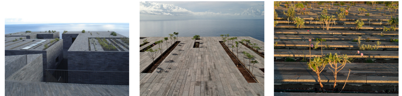
Cubierta transitable de basalto y vegetación P. David. Centro de artes Casa das Mudanças © F. Guerra y L. Finotti
