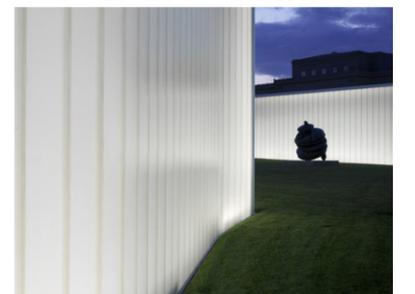
Fachada de vidrio moldeado en U con difusor luminico aislante PMMA
