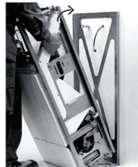
COLOCAR EL WC EN LA BASE DE ESPERA
