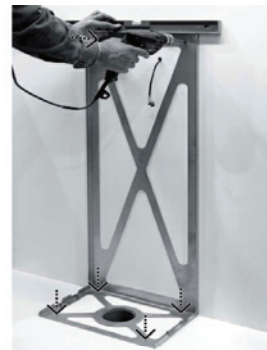
INSTALAR LA BASE DE ESPERA A NIVEL
