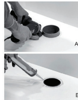
A.CORTAR EL TUBO DE DESAGUE B.SELLAR EL PERIMETRO DEL TUBO CON SILICONA
