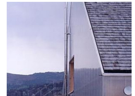
Canalón oculto en cubierta de madera - Florian Nagler architekten. Haus und Atelier Lang-Kröll © Stefan Müller-Naumann
