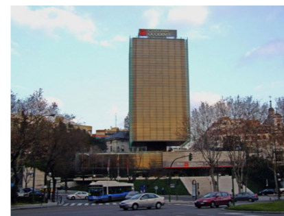
Doble fachada ventilada de vidrio Rafael de la Hoz. Torre Castelar
